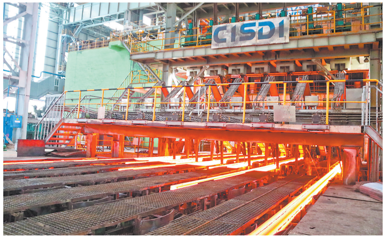
广西贵港钢铁集团公司一季度实现工业产值32.6亿元，同比增长16.8%；营业收入62.35亿元，同比增长19.9%；上交税金（含进口环节增值税）3.59亿元，同比增长32.4%。图为近日该公司炼钢总厂电炉分厂连铸作业场景。
