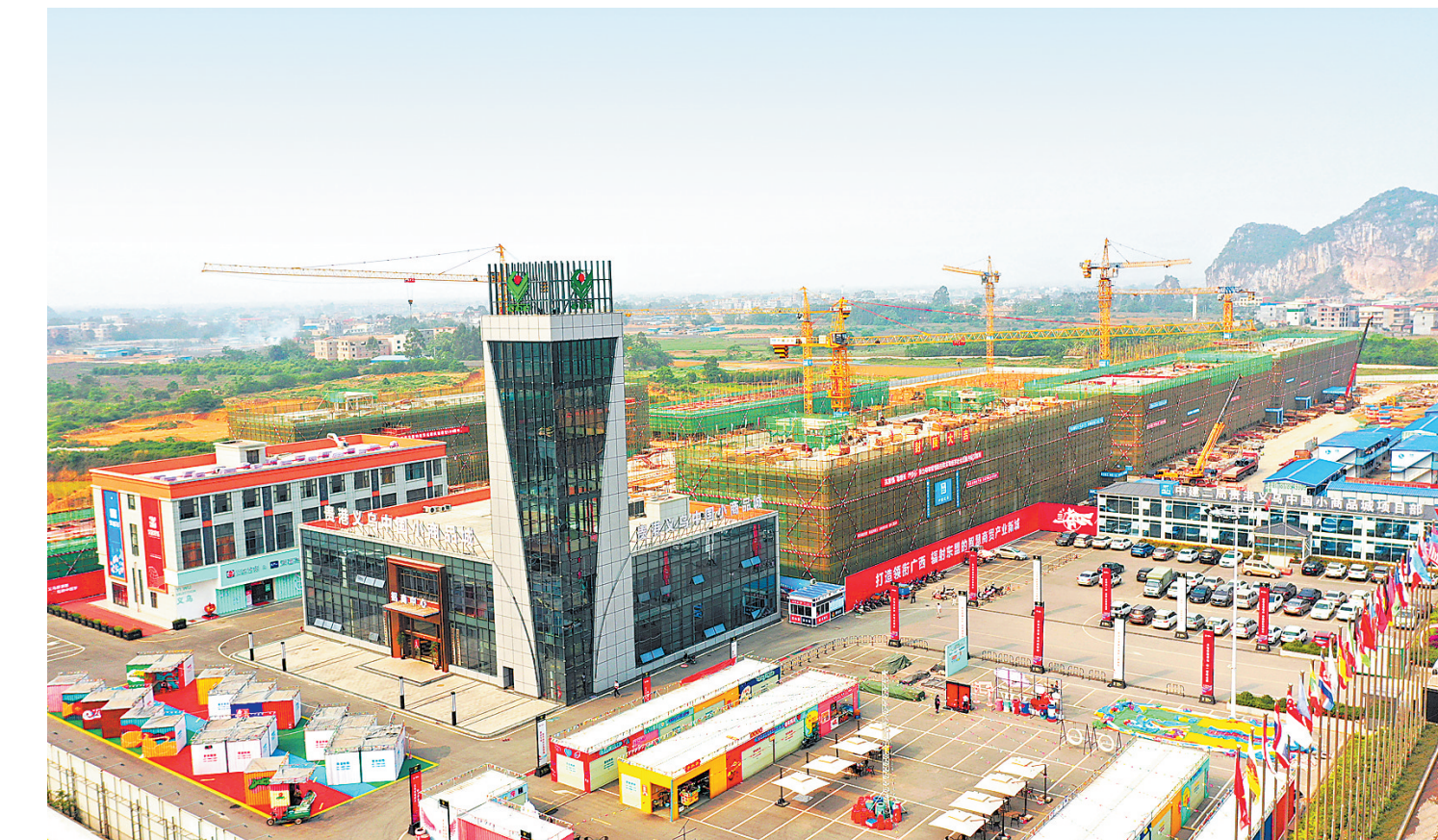
贵港义乌中国小商品城位于港南区南环路南侧,项目总投资110亿元,规划建筑面积300万平方米。项目分五期建设,由智慧市场区、工业互联网双创中心、公路港物流区、生活配套区四大功能板块组成。目前,一期工程六幢主体结构已经封顶,进入装修阶段。图为项目建设现场。(记者张庆杰摄)
