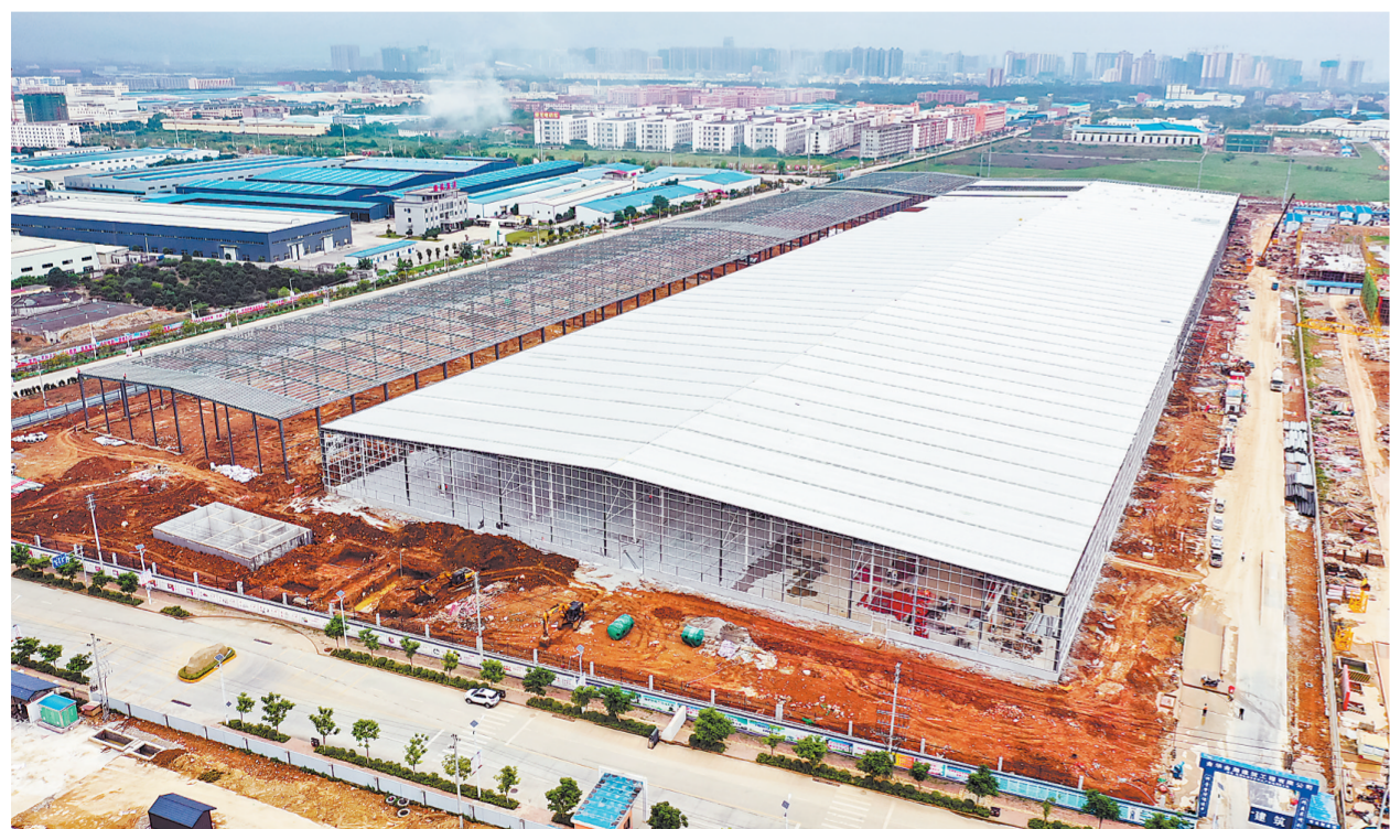
位于中国-东盟新能源汽车生产基地的绿源电动车生产基地项目总投资4亿元，项目建成后预计年产能达30万辆，年产值达7.5亿元。目前，该项目正在进行钢结构厂房主体吊装和食堂、办公楼基础建设工作。图为项目建设现场。(本报签约摄影师岑记华摄)
