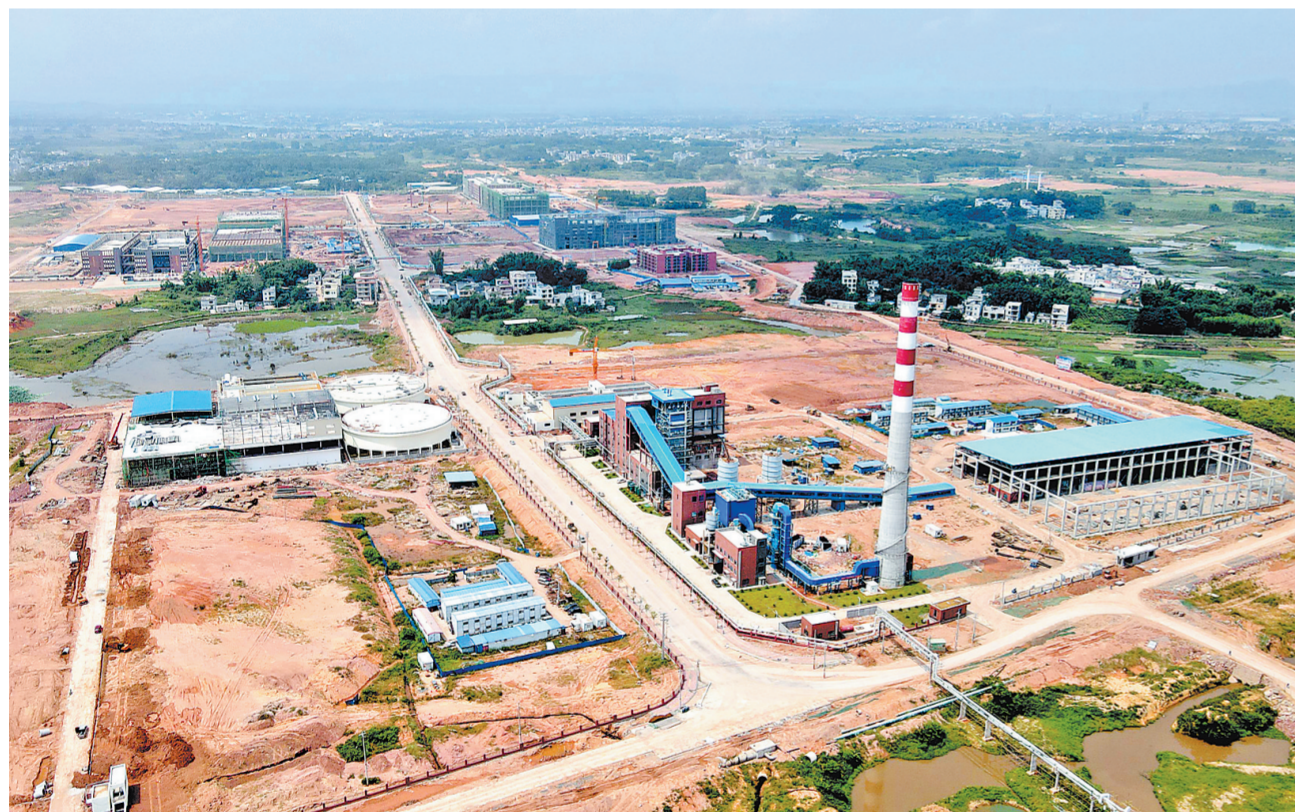
广西世纺投资集团有限公司纺织服装产业园位于平南县长成绿色生态园区内,拟入驻企业共54家,总投资120亿元。目前已开工企业16家,投资额达15.5亿元,投产和近期计划投产9家。图为8月8日拍摄的项目建设现场。(记者张庆杰摄)
