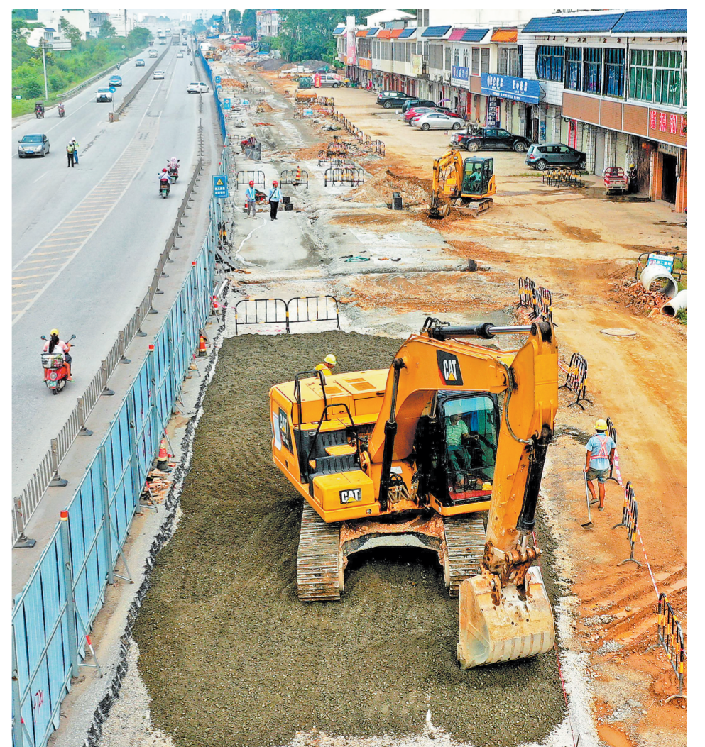
G358南广铁路桥附近至西环立交一级公路拓宽改造项目(根竹段),拓宽改造道路长7800多米。目前项目正在开展水稳层摊铺和路缘石安装工作,下一步将进行沥青铺设施工,全段计划今年年底实现通车。图为8月20日项目施工现场。(记者张庆杰摄)
