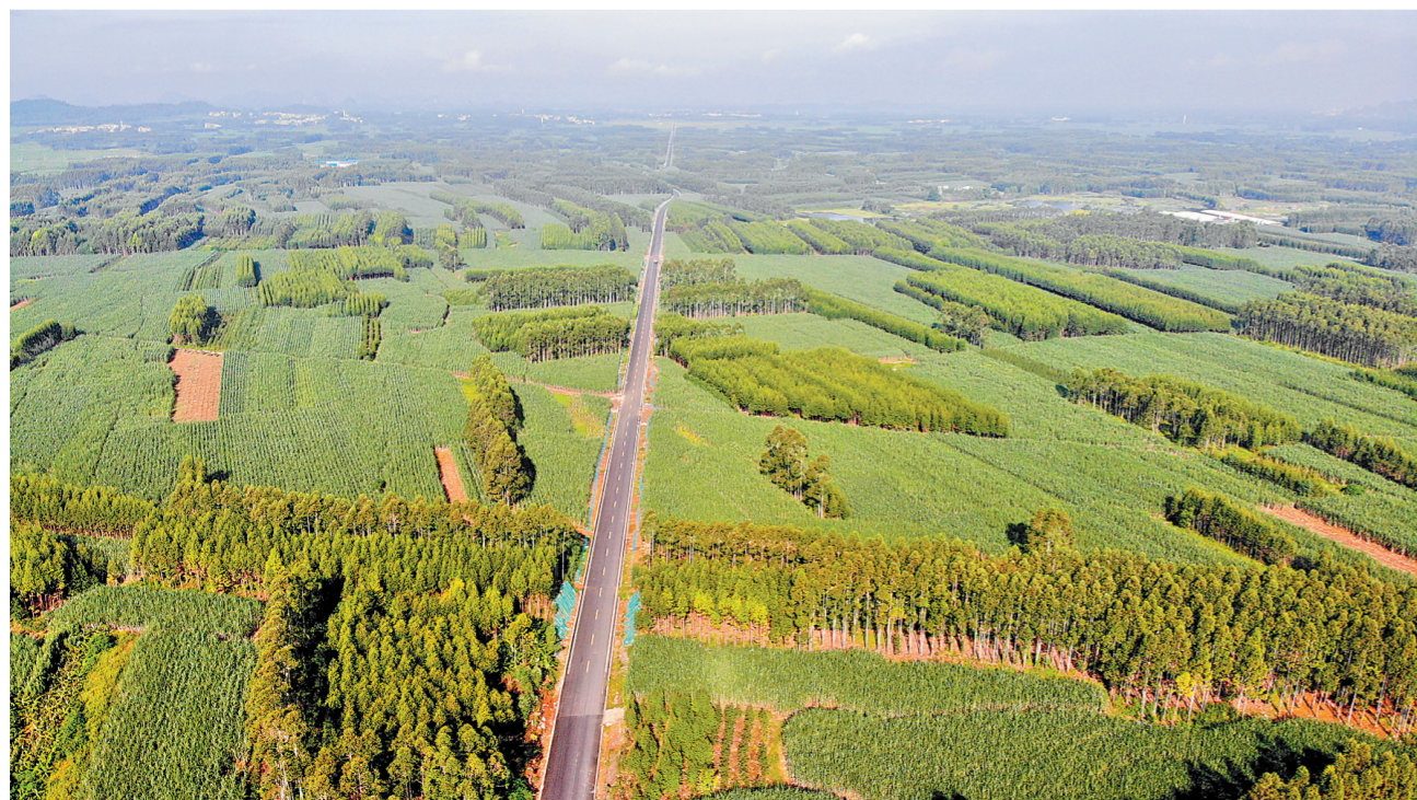
九渡湖大道项目起于下穿汽车大道,道路由东向西经桐尾、龙寨,至九渡湖景区东门附近后绕九渡湖景区途经万隆、万塘、滑水等村,终点接九渡湖景区南门;道路全长约10.64千米,设计速度为30千米/小时。目前,主线主体工程已完成并达到通车条件,正在进行标志、标线及护栏等附属工程施工。图为8月27日拍摄的项目现场。(记者易昉摄)
