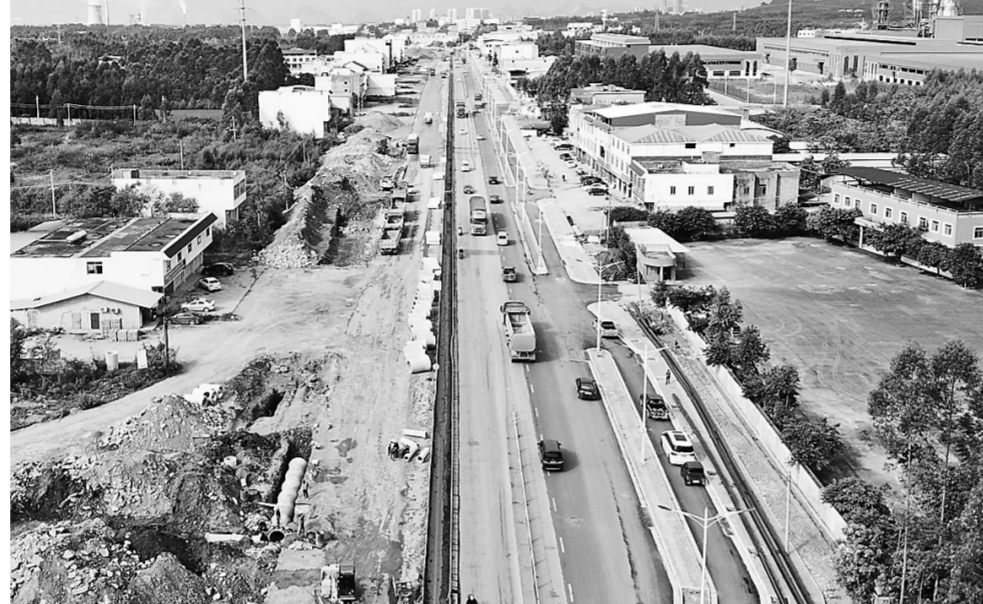
G358覃塘至黎塘界一级公路（覃塘桥村段）改造工程项目是“贵港市九路两桥”重点项目之一，工程起于覃塘区覃塘街道南广铁路桥底，止于金港大道桃源小区旁，拓宽改造道路长7830米，按城市主干道标准建设，总投资3.3亿元。目前，工程已完成总投资的52.7%，正在进行南广铁路桥至根竹桥路段雨污水管、路基填筑施工，根竹桥至康顺养老院路段给水管、路灯施工。图为11月10日，该路段恢复半幅通车现场。（记者黄倩倩摄）
