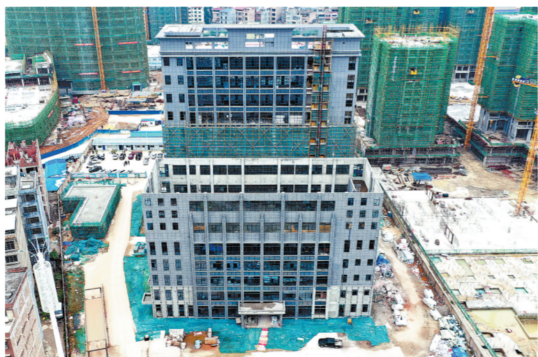
一手抓疫情防控,一手抓项目复工。2月16日,贵港市疾病预防控制中心整体搬迁项目正在紧锣密鼓地施工中。据了解,该项目总用地面积为13332平方米,总建筑面积15559平方米,计划今年5月竣工。(记者郭哲摄)
