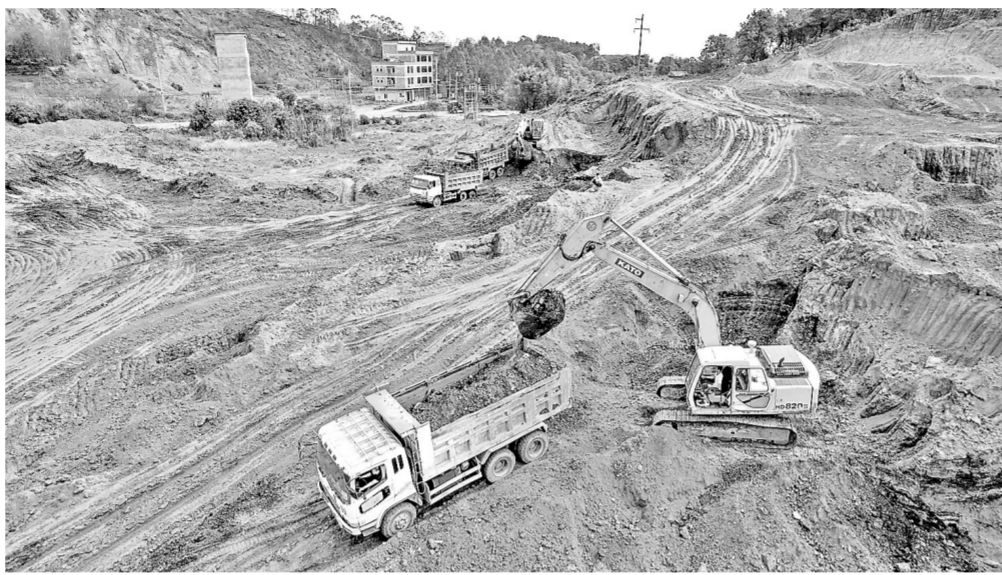
桂平市木乐镇纺织服装产业园总体规划面积1.5万亩，分三期工程实施。目前，该项目在开展3000亩的一期工程建设，已完成700亩土地平整。目前已有143家省内外企业签订入园投资意向书，投资规模超160亿元，5家规模以上企业完成入园。图为3月18日的项目建设现场。（记者杨小露摄）
