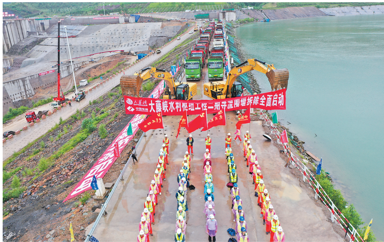
5月1日，大藤峡水利枢纽工程右岸二期围堰拆除工程启动，标志着右岸工程建设进入新阶段。二期围堰拆除是大藤峡工程2022年第二大攻坚目标，计划在8月31日前完成上游横围堰泄水闸段、10月30日前完成全部二期围堰拆除工作，工期短、任务重，整体拆除难度在国内在建工程中属罕见。（记者张日芳 通讯员李昆峰摄影报道）
