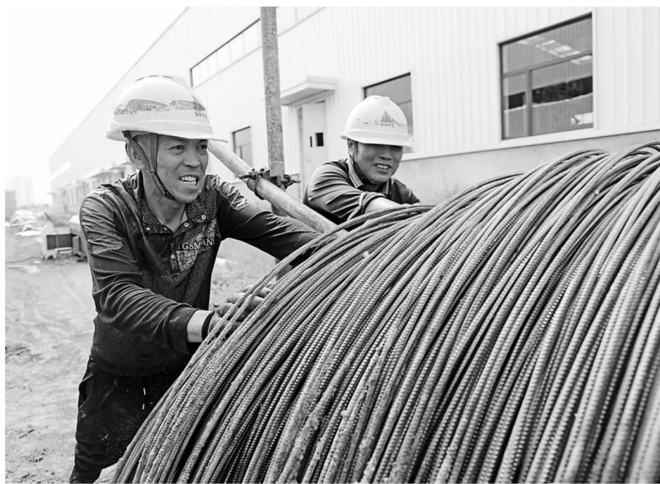
4月29日，建筑工人在修正集团贵港医药产业园抢抓工程进度。（首席摄影记者张庆杰摄）
