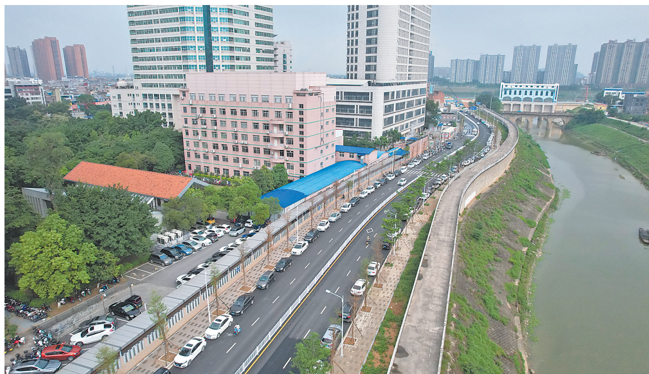
近日,市中心城区人民路(建设西路至小江桥段)市人民医院路段完工通车。人民路工程道路设计全长2024米,其中市人民医院段道路长550米。该路段的顺利通车,改善了周边群众和市民前往市人民医院总院、儿童诊疗中心就医的交通出行条件,缓解了该院正门路段的交通压力。(记者梁棋摄)
