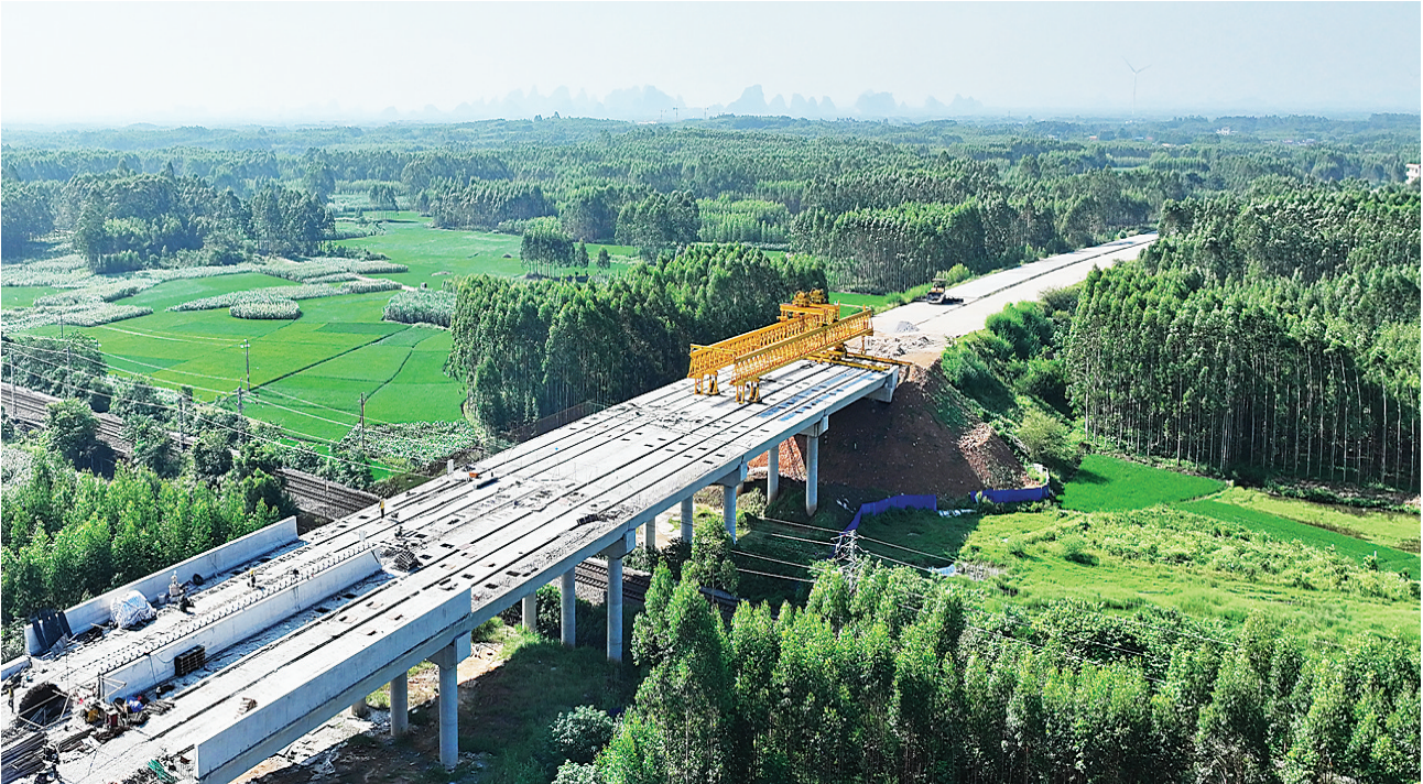
9月1日凌晨，覃塘城区至石卡产业园一级公路K1+572.249黎湛铁路跨线桥工程项目完成最后一片箱梁架设。至此，该桥5跨共40片箱梁架设全部完成。据悉，覃塘城区至石卡产业园一级公路长19.961千米，路基宽24.5米。图为公路施工现场。（见习记者陆颖敏 通讯员黄家胜摄影报道）
