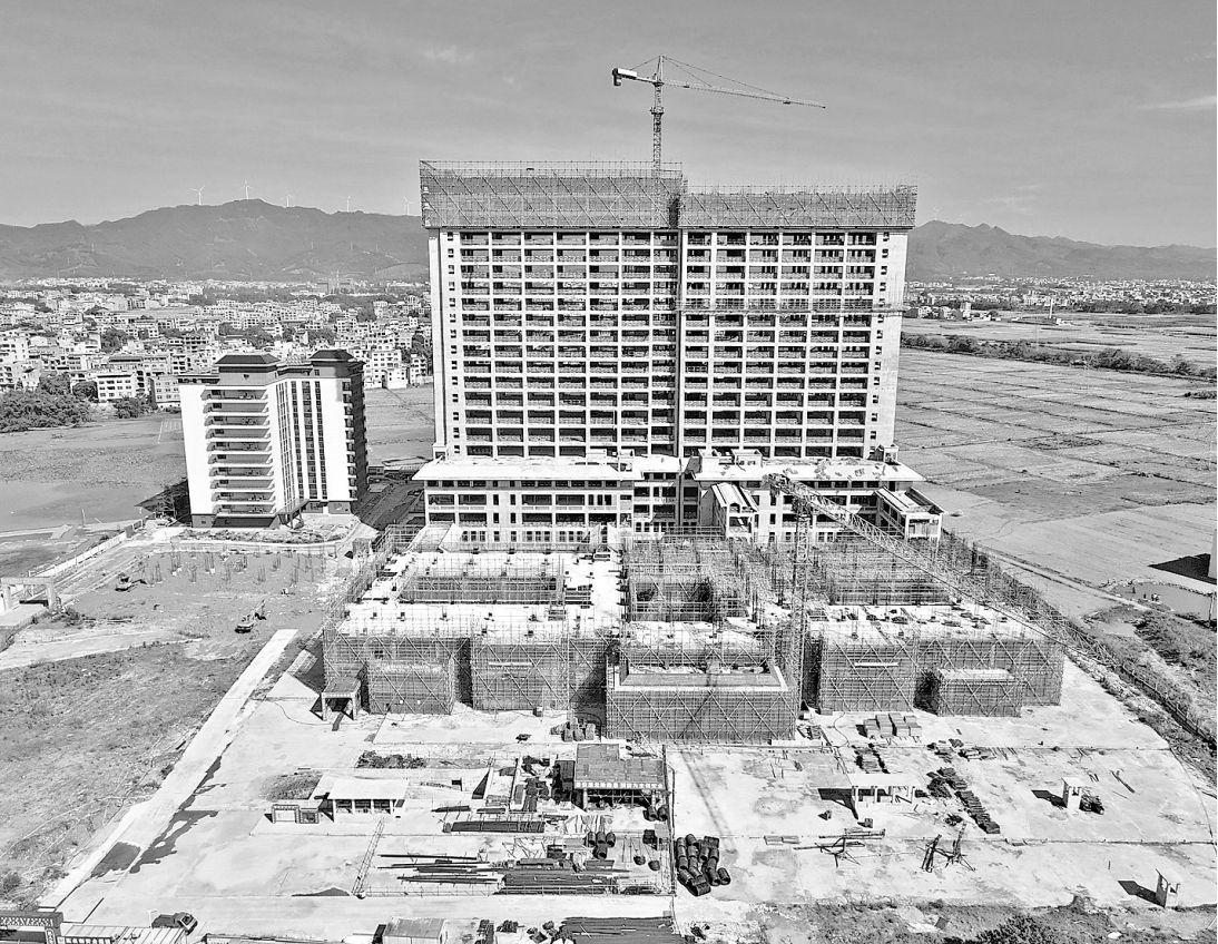
贵港市中西医结合骨科医院整体搬迁项目于2024年第四季度获得地方政府专项债资金6000万元，目前该项目的门诊住院综合楼已完成22层主体结构（设计23层）及2-5层砌体施工；门诊楼在建3层主体结构施工（设计5层）；制剂楼完成基础施工。项目建成后，医院服务能力、就医环境将得到全面提升，可更好地满足人民群众看病就医需求。
