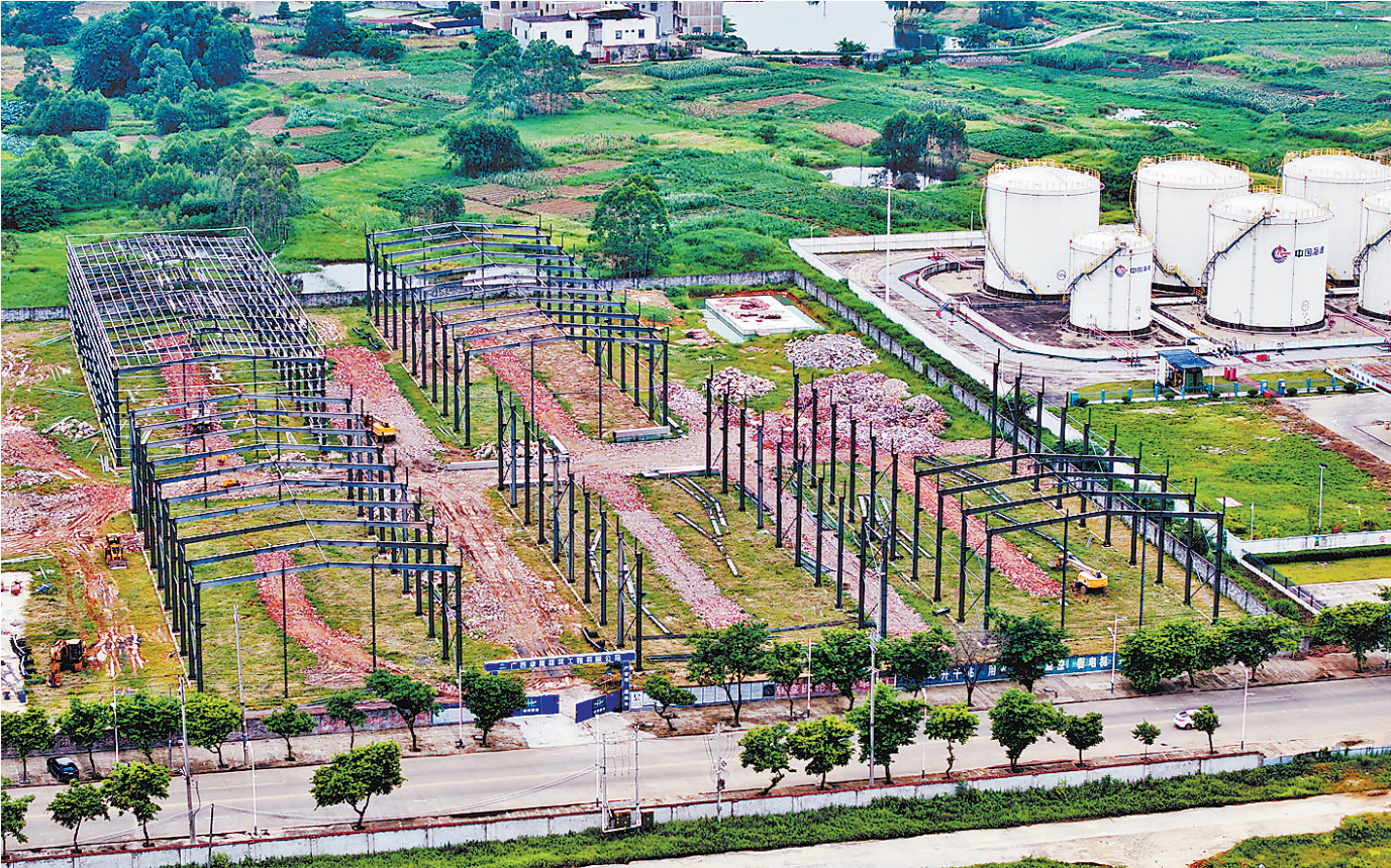
浔江环保建材公司装饰装修材料项目位于桂平市长安工业园，总投资1.2亿元，主要生产环保新型装修材料，建成达产后预计年产值约1.3亿元，带动约200人就业。该项目今年5月开工建设，目前已完成五间厂房的钢柱钢梁安装，正在进行屋面安装，预计今年年底竣工。图为项目施工现场。
