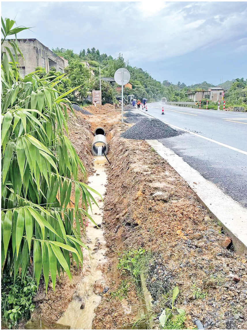
桂平公路养护中心正在建设涵管排水。全媒体记者陆颖敏 通讯员莫平摄影报道
